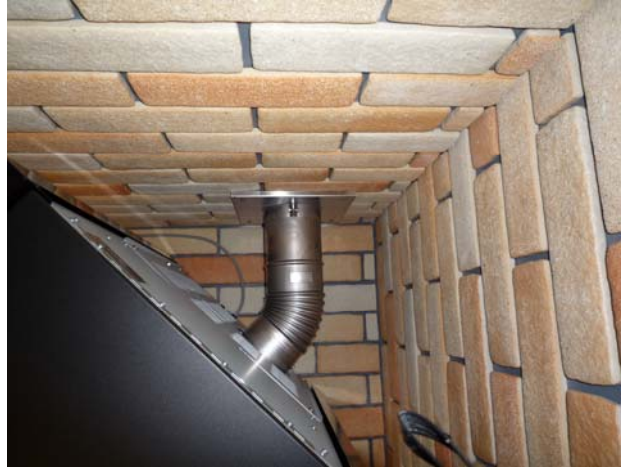
・ ストープ背面の状況（コーナー設置）
