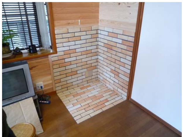
・ コーナー部，敷板は素焼き耐火レンガ仕上げ
