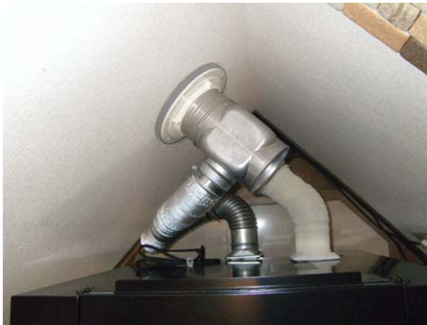
・ストーブ背面部の状況
